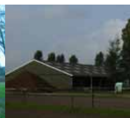
Aan- en bijbouwen zijn onderdeel van het hoofdvolume doordat de daklijn wordt doorgetrokken.
