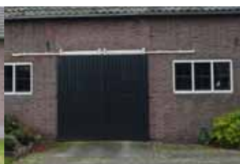
Geen goot, afvoer gecementeerde plint met grindstrook
