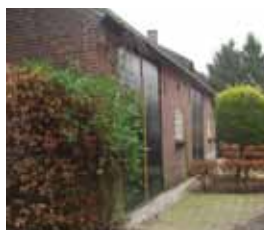
Geen goot, afvoer gecementeerde plint met grindstrook
