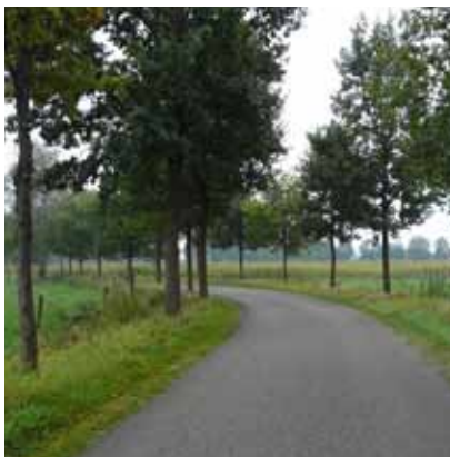
Wegprofiel 3.5 meter breed, materiaal is asfalt met een afstrooilaag
