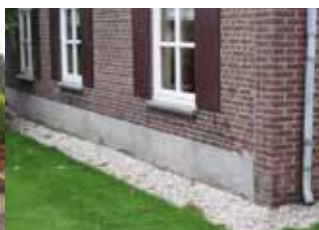
Geen goot, afvoer gecementeerde plint met grindstrook
