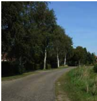
Wegprofiel 3.5 meter breed, materiaal is asfalt met een afstrooilaag
