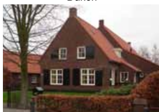
Aan- en bijbouwen zijn onderdeel van het hoofdvolume doordat de daklijn wordt doorgetrokken.
