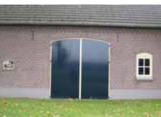
Geen goot, afvoer gecementeerde plint met grindstrook
