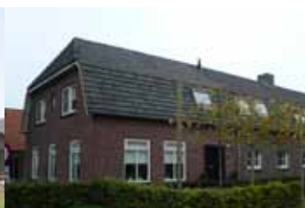
Mansarde kap: dakpannen
