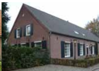
Kopgevel van baksteen met randpannen
