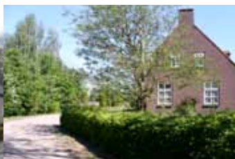
Kopgevel met schoorsteen
