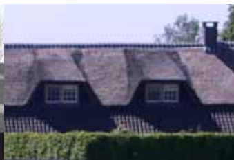
Grote dakkapellen slepend vanuit de nok met een lessenaarsdak
