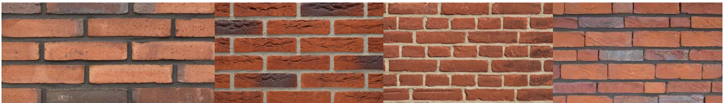
Metselwerk in een warme rode tint
